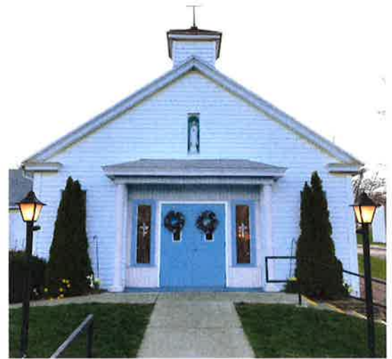
Elba Site 65 S. Main St., Elba
