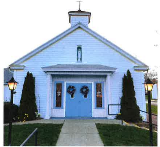
Elba Site 65 S. Main St., Elba
