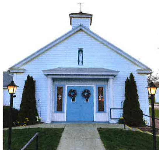
Elba Site 65 S. Main St., Elba
