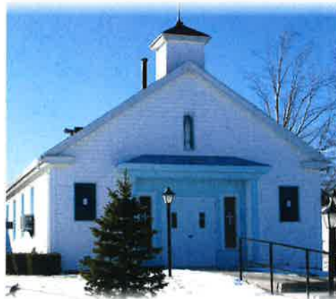
Elba Site 65 S. Main St., Elba
