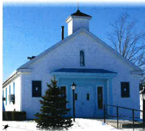
Elba Site 65 S. Main St., Elba
