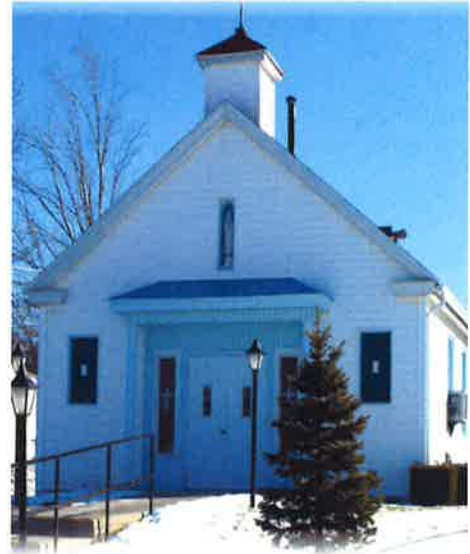
Elba Site 65 S. Main St., Elba
